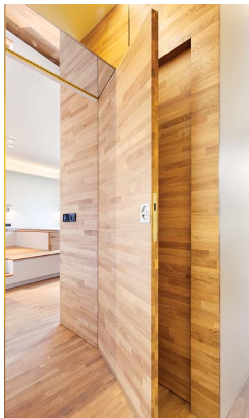
Jednotlivé místnosti jsou oddělené posuvnými a výklopnými dveřmi, které jsou při běžném provozu skryté v obkladu.
